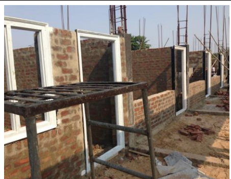
Bau des neuen Kinderheims (Stand: April 2014)
